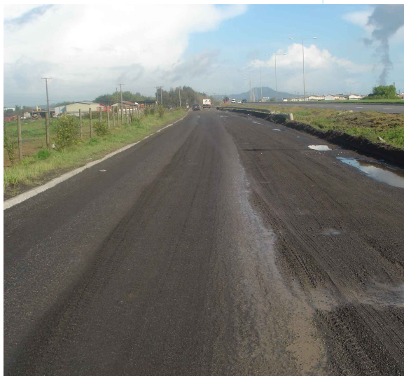
Perfilamiento calle Areneras
