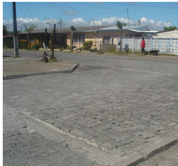
Reparación calle Corral esq. Ramuntcho
